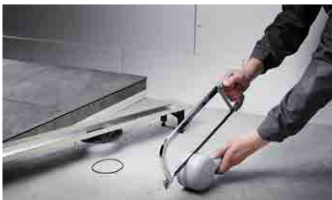
Standardni odtok je mogoče preprosto skrajšati na mestu vgradnje in ga tako pretvoriti v sanacijski model.
