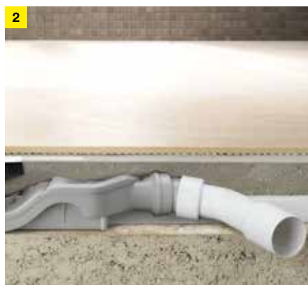
Slika 2: Izjemno ploščat: poseben odtok, namenjen sanacijam, skupno višino znižuje na 70 mm.
